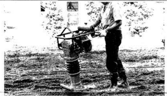
(柔らかい土も素早く締め固め)
