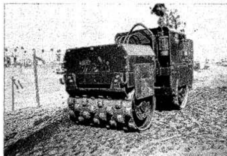
(作業中の10Gローラー)
