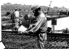
分電盤を経て5台の「トントン」は運転される。
