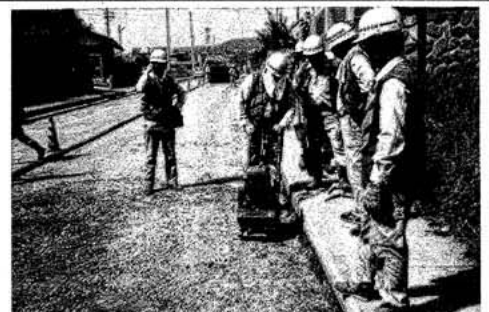
(路床転圧中のR85型)
