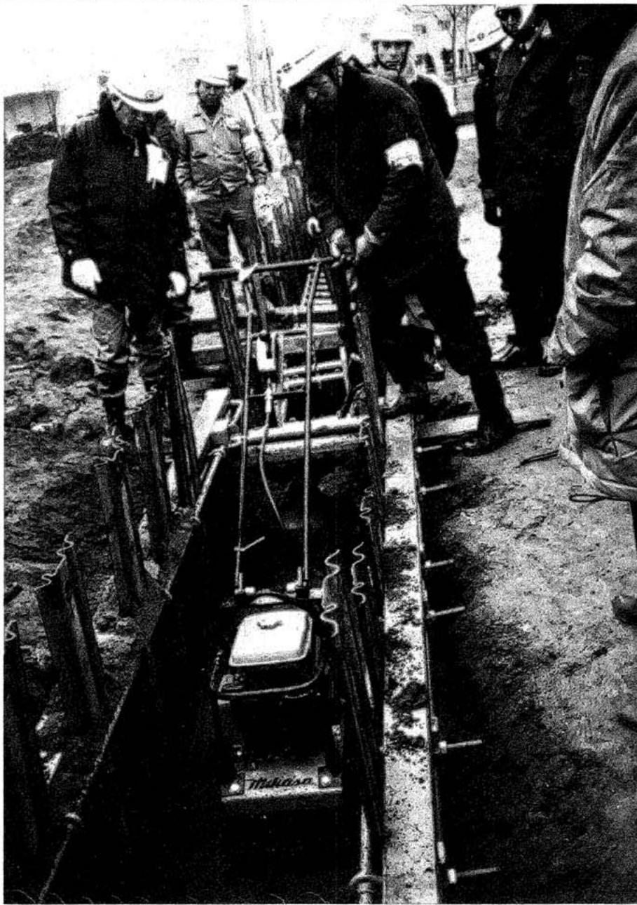
(東北通信建設機材置場での溝内輾圧試験の状況)
