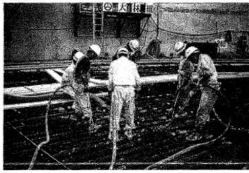
(高周波バイブレーターを使い高品質の優れたコンクリートが打設される)
