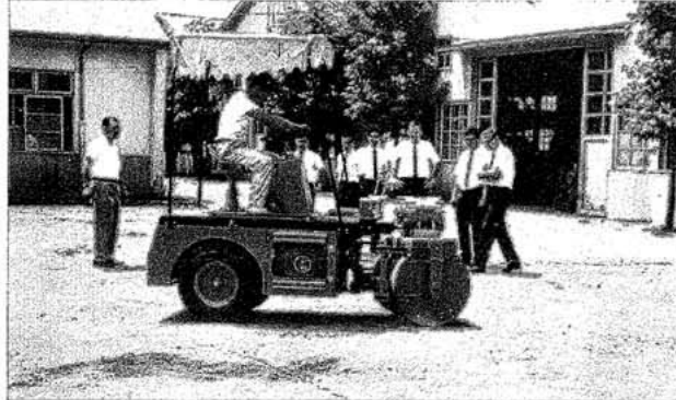
館林工場にて 中型振動ローラーの運転説明
