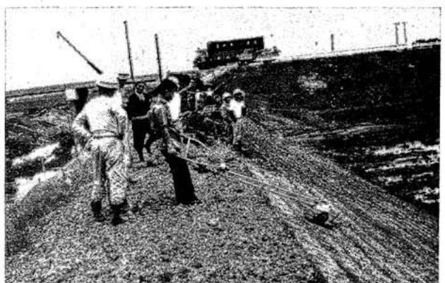
築館市4号国道工事現場 高勝組、上田建設施工
