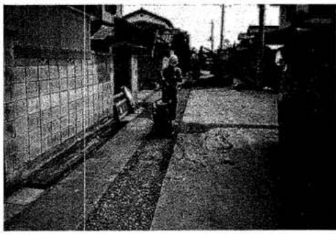
(自動車を通っても沈下しないほどよく締まっている)
