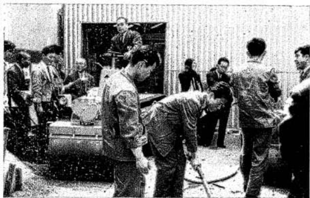
錐振型中部振動機と中型振動ローラーの実演
