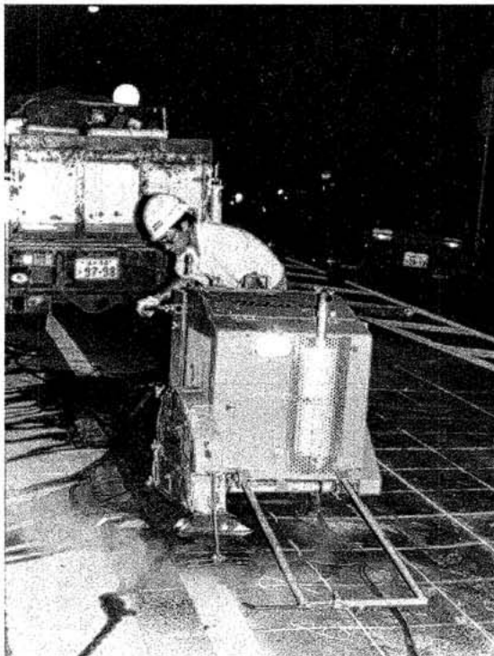
(夜間の切削作業)
