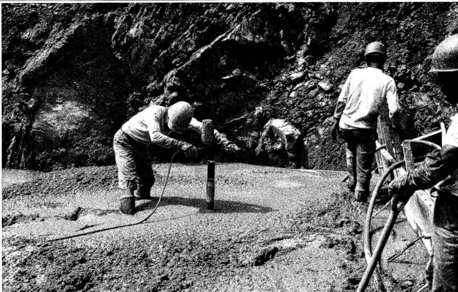
(長野県富士見町の現場にて、錐振電直70型バイブレーター)
