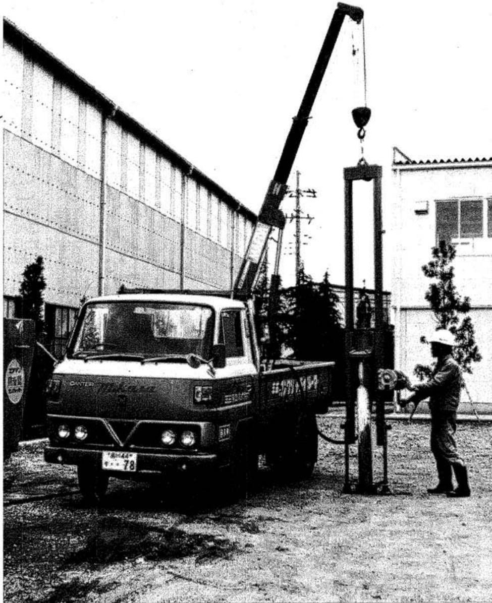
(クレーン用打込ガイドに取付けられたMAH-90型エアハンマー)
