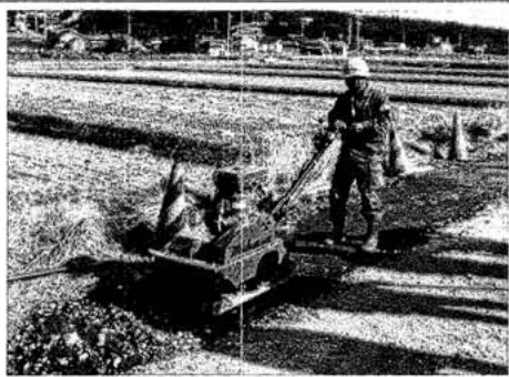
一度で碎石を締固める。両側にエクステンション・プレートを付けている。
