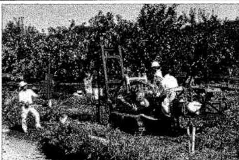
(防風柵のポール打込み状況)
