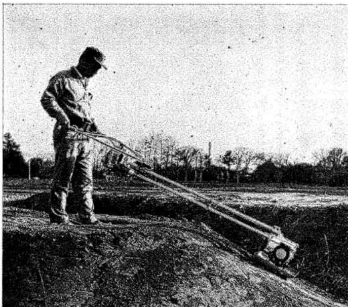
春日部工場内で試運転中の法面仕上機
