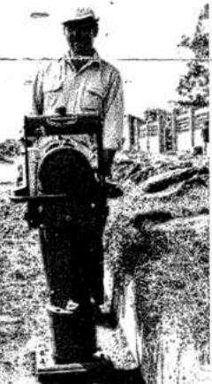
(サンタクルスの道路建設現場で見たMTT)
