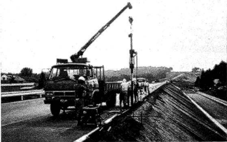
(浜田専用道路のポール打込現場)
