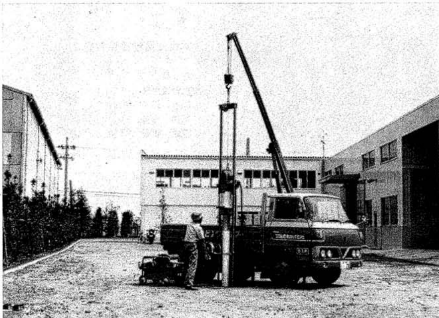
(ポールハンマーと打込ガイドを取付けたクレーン車)
