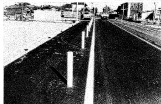
打込み終ってきれいになったボールの列
