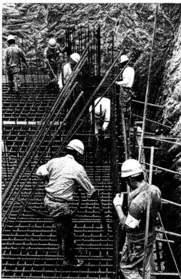
(新60型インヘッダーを使つての作業)
