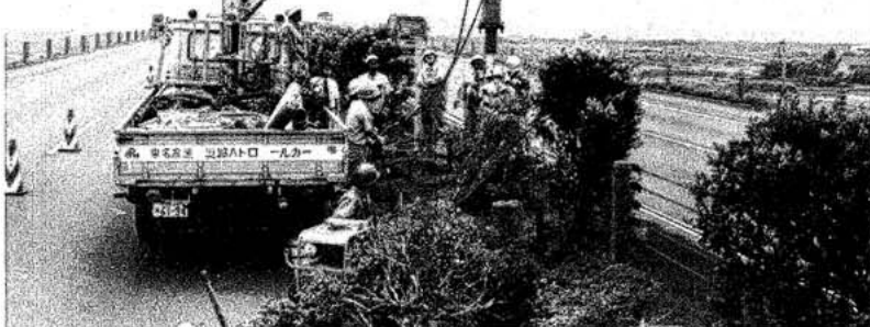
(東名高速・中央分離帯の事故復旧作業)
