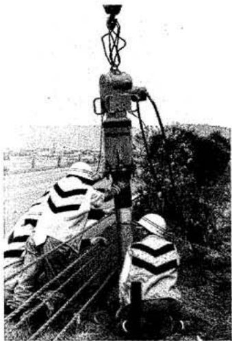
今春弊社がガードレールのポール打込み専用機として開発した「MOP-12型新製品」油圧式MOP-12型ポールハンマーの現場テストを六月四日(金)、日本ロード・メンテナンス(株)井ノ口支所(長崎所長殿)管内の東名高速道路中央分離帯の事故復旧作業現場に行き、極めて良好な成績を取った。
