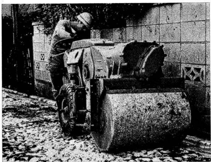
MRV-10型 小型振動ローラーの作業状況
