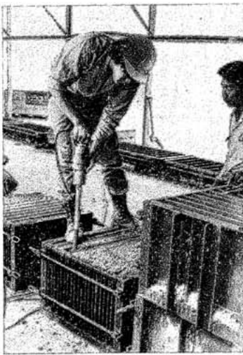
(25型で薄板の打込み作業)
