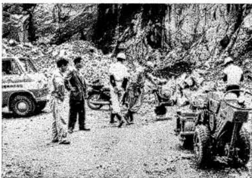
石越町千葉土建現場にて
