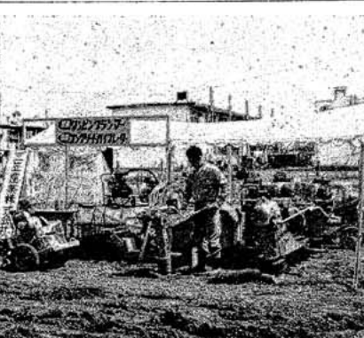
左がパイプロコンパクター中央と右がタンピングローラー
