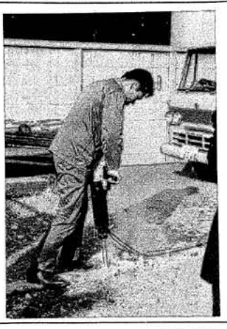
(油圧ブレイカーによる破砕試験)
