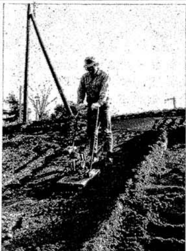
（法面（傾面）の振圧状況）
