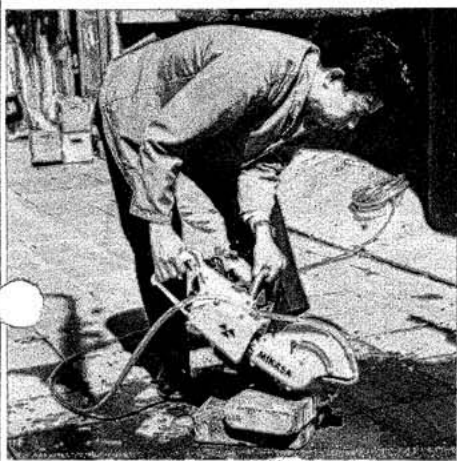
(コンクリートの敷石を切断)
