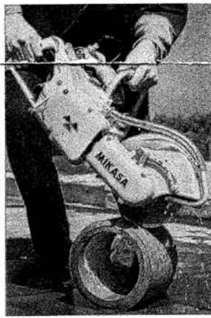
(ヒューム管の切断)
