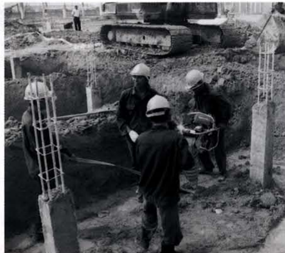
現地ベトナムでは建設工事が盛んに行われています。写真はホーチミン市の住宅工事現場です。
