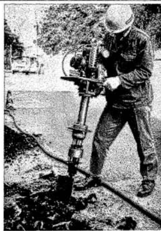
アスファルト舗装工事における土の掘出し作業
