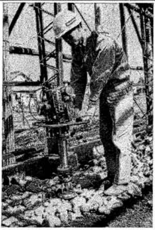
鉄骨ガレージ内の基礎突き固め作業
