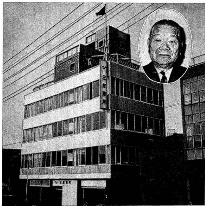
増築完成した三笠産業本社ビルと京谷社長
