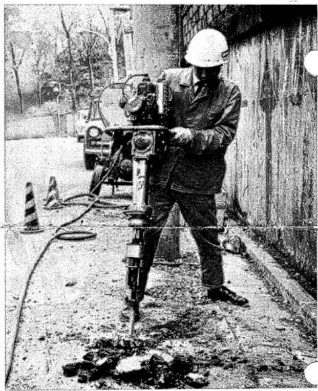
三笠万能ブレーカーの特徴 破する、掘る、叩く、固める
