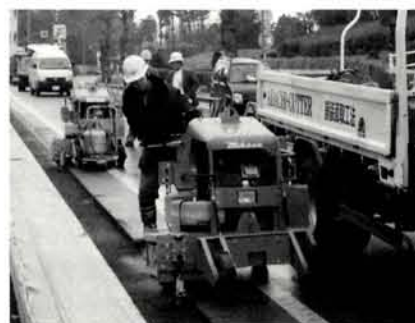
バーナー付(後方)とバーナー無し(前方) 2台で作業
