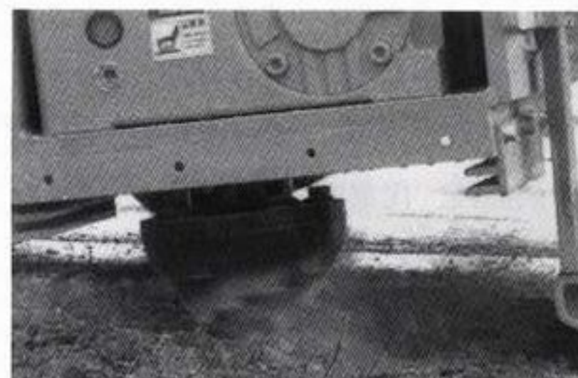
垂直の切断面をビットで面取りする
