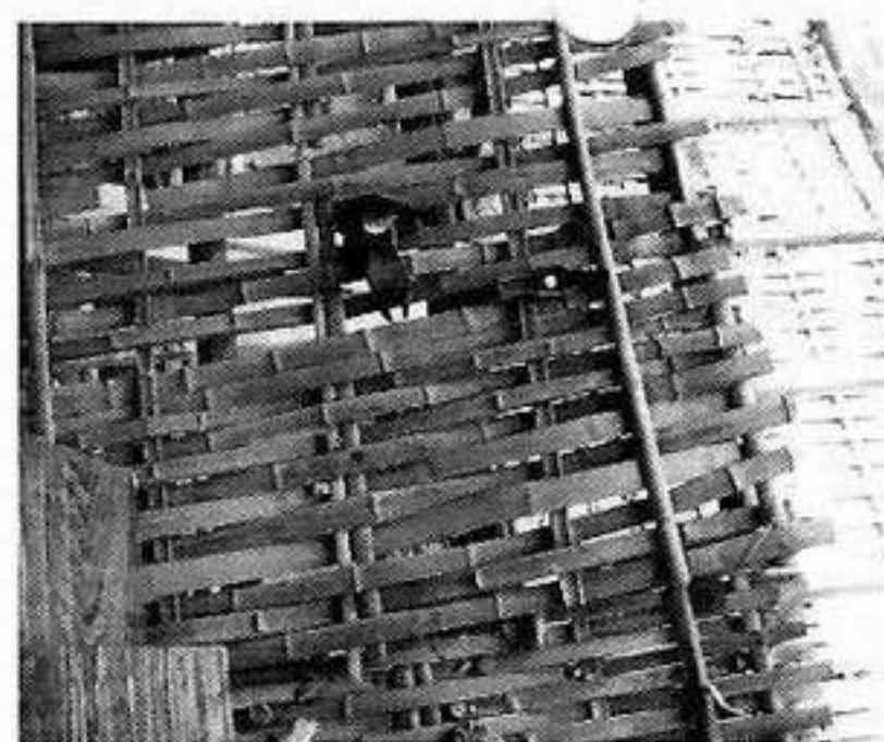
足場を上から覗いたところ
