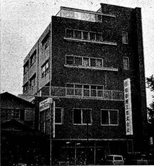
和田機工（株）本社々屋全景
