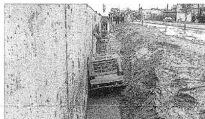
共同溝工事現場にて
