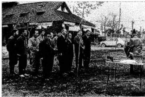
(田島宮司の司祭で工場地鎮祭を挙げる)
