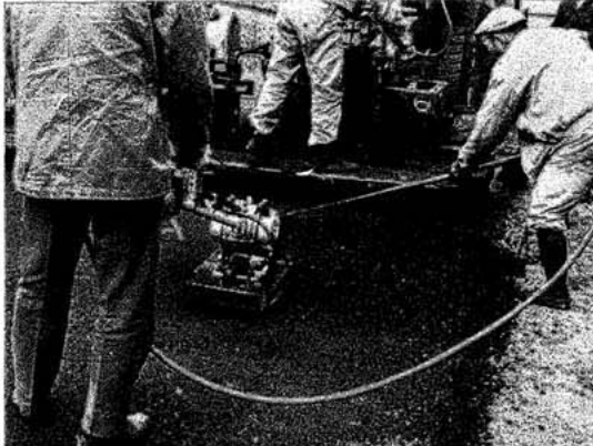
アスファルトフィニッシャー通過後の加熱輾圧仕上(手前の仕上面は本機を通した一回の輾圧面)
