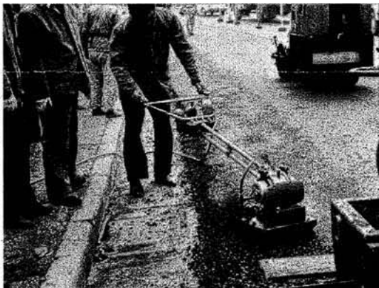
加熱アスファルト舗装工事に於ける路肩の輾圧仕上げとローラーの鉄輪によって出来る条痕直し
