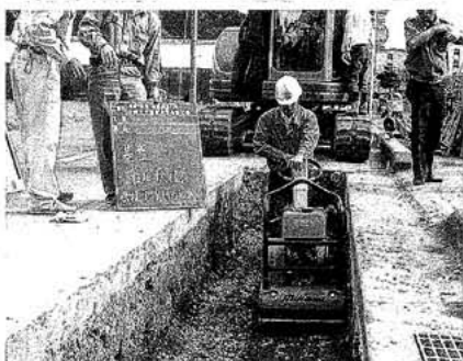
試験材料：破碎コンクリートRC-30 (静岡県盛り土材基準に適合している)
