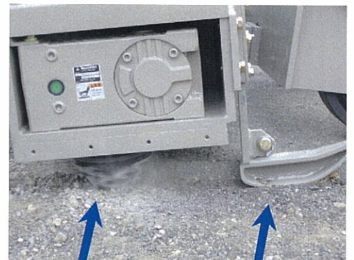
ビットにて切削 切削面ガイド
