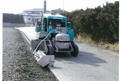
ロードヒーター使用 前側状況
