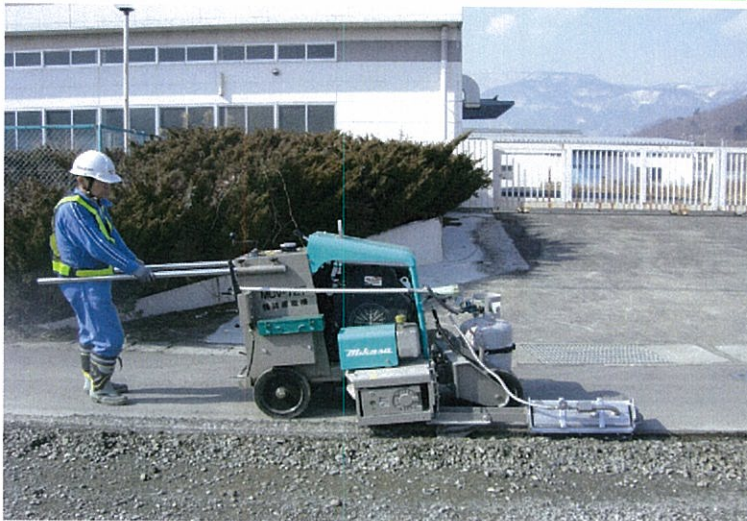
ロードヒーター使用にての面取り作業
