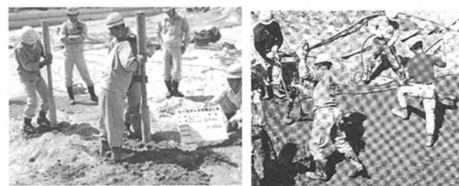
写真—61 凹部の杵突き
