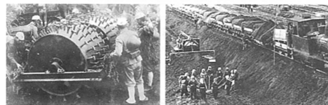
写真-43 設営隊の棘付点圧機
