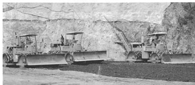
写真—56 寒河江ダムの825
