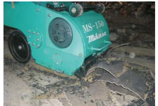
P タイル剥がしの現場
