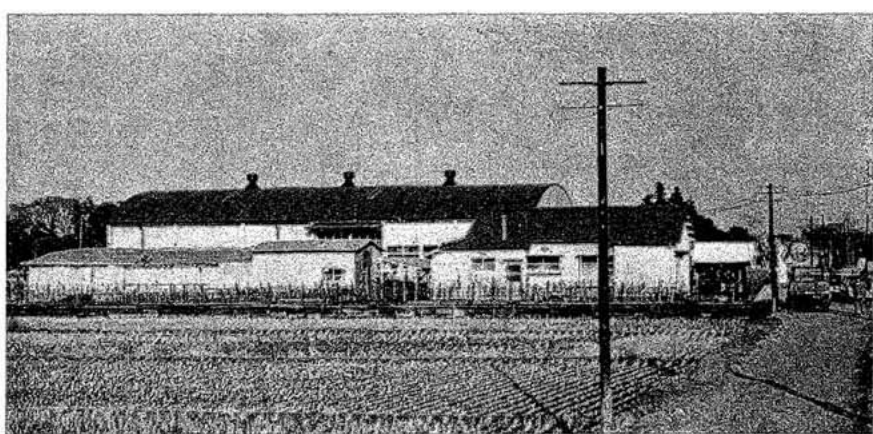
(春日部工場の遠景)
